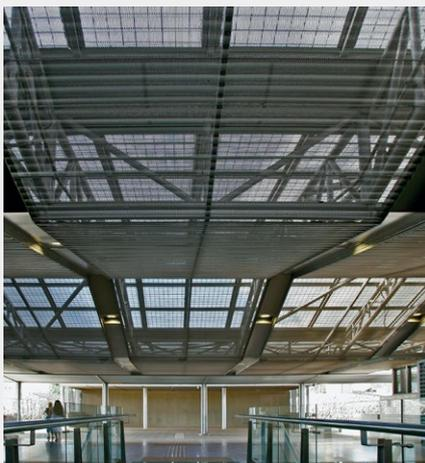
O Softwave 50 Hunter Douglas é um painel single skin de geometria de linhas planas e curvas, com raio de 48 mm. O painel pode ser liso ou perfurado. Quando perfurado e utilizado externamente, o produto apresenta função de brise, auxiliando no controle solar. Pode ser aplicado na horizontal ou na vertical, com encaixe dos painéis do tipo macho-fêmea fixado na parte plana do painel.
