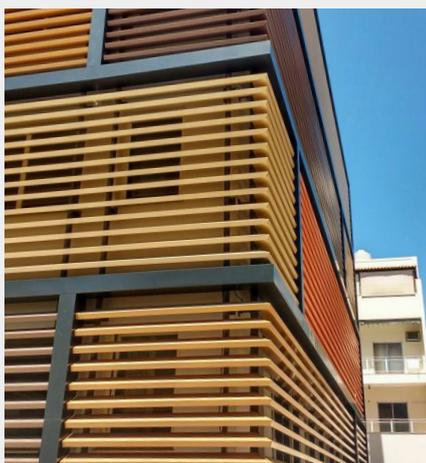
O Quadrobrise XL é um brise de aparência robusta, especialmente desenhado para projetos de grande porte. Possui três dimensões distintas, 100, 200 ou 300 mm de profundidade, podendo ser instaladas conforme necessidade específica de controle solar e / ou visual de cada projeto. Apresenta tampas laterais, utilizadas para fechamento das extremidades dos painéis. Quando aplicado internamente, as tampas laterais são opcionais.
