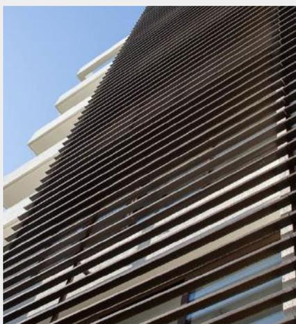
O Quadrobrise 25x50, 25x75 e 40x60 Hunter Douglas foram dimensionados para a utilização em fachadas e aplicações zenitais. O sistema é composto por um perfil de sustentação (porta-painel), um painel de seção retangular e tampas laterais, os quais permitem que esse brise tenha um aspecto homogêneo quando visto interiormente e exteriormente. A distância entre eixos de lâminas (passo) deverá seguir projeto arquitetônico, conforme a necessidade de proteção solar e/ou controle visual.
