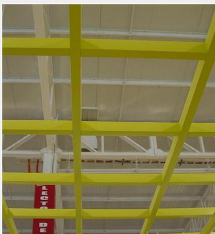
O forro Macrocell Hunter Douglas é um forro aberto com perfis em forma de "U" que possuem 50 mm de largura e 74 mm de altura. Apresenta 4 modulações diferentes e pode ser composto com bandejas metálicas criando módulos abertos e fechados. O design do produto possibilita diminuir o pé direito de grandes vãos, mantendo a amplitude do espaço. O fato de ser um forro com grande abertura entre as grelhas garante o acesso ao entreforro sem a necessidade de desmontagem.
