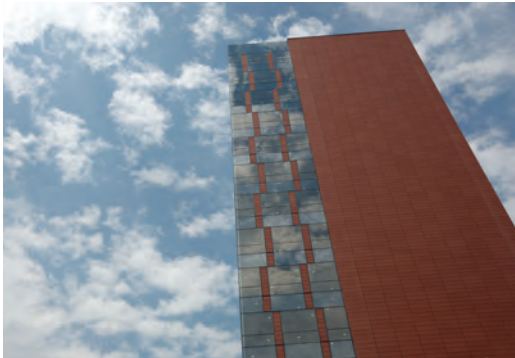
Edifício Toulon - Brasil Arquiteto: Roberto Leme
