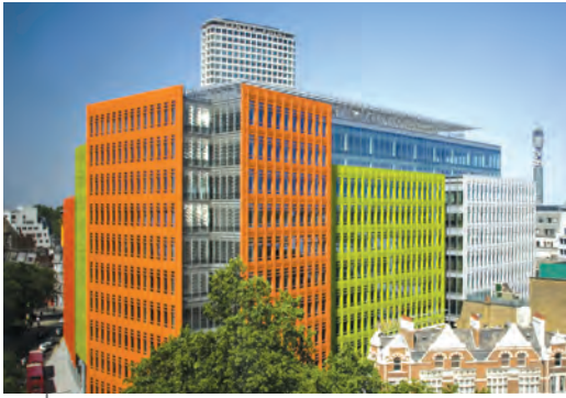
CSG Central Saint Giles - Inglaterra Arquiteto: Renzo Piano
