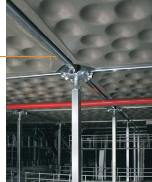
Detalhe para fixação da longarina
