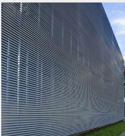
Os brises Celosia Hunter Douglas são ideais para necessidades de controle solar e ventilação, sendo compostos por lâminas lisas ou perfuradas. O distanciamento entre eixos de lâminas (passo) é variável, conforme requisito de projeto, permitindo diferentes soluções arquitetônicas. Esse produto é recomendado para aplicações internas ou externas, podendo ser utilizado em edificações de usos diversos.
